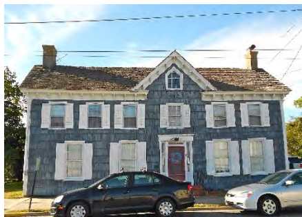
Peter S. Faucett House 5
